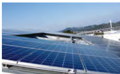
太陽光発電システム
