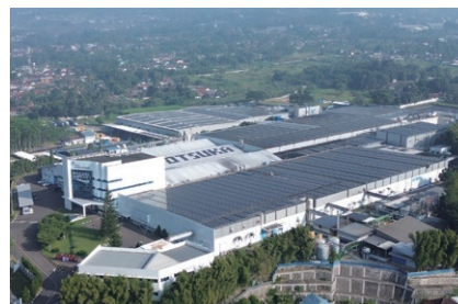
PTアメルタインダ大塚 スカブミ工場の太陽光発電設備
