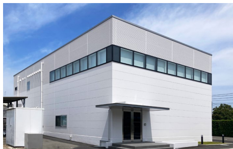
大塚グループエネルギー管理棟
