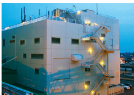
大塚製薬工場：停電時に自動で点灯するLED防災ライトを避難経路・避難場所に設置
