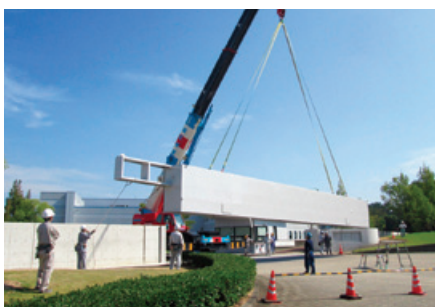
大塚製薬工場：松茂工場の外周防潮堤の設置
